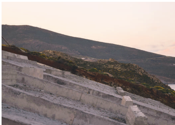
Κατά την κατασκευή τοποθετήθηκαν αντεστραμμένες δοκοί στην οροφή, οι οποίες λειτουργούν ως οριζόντια φράγματα και αναστέλλουν την ταχύτητα της ροής του νερού στην κεκλιμένη οροφή. Φωτογραφία: MOLD Architects.
