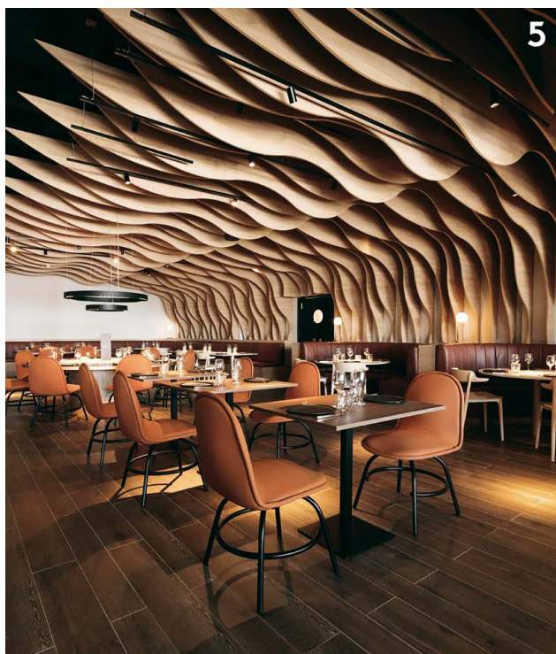
5. Ξύλινα ακουστικά πετάσματα στο εστιατόριο "Ladon Brasa & Grill".
