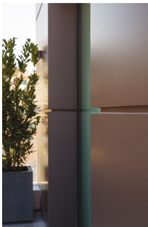
ΜΕΤΑΞΥ ΤΟΥ ΤΟΙΧΟΥ ΚΑΙ ΤΟΥ ΥΛΙΚΟΥ ΕΠΕΝΔΥΣΗΣ ΜΠΟΡΕΙ ΝΑ ΤΟΠΟΘΕΤΗΘΕΙ ΜΟΝΩΤΙΚΟ ΥΛΙΚΟ, ΒΕΛΤΙΩΝΟΝΤΑΣ ΕΤΣΙ ΤΗΝ ΑΝΕΣΗ ΔΙΑΒΙΩΣΗΣ ΚΑΙ ΤΗΝ ΕΝΕΡΓΕΙΑΚΗ ΑΠΟΔΟΣΗ.
