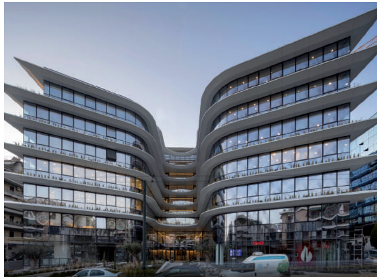
ΚΤΙΡΙΟ ΓΡΑΦΕΙΩΝ THE ORBIT, ΑΜΠΕΛΟΚΗΠΟΙ ΑΤΤΙΚΗΣ. ΑΡΧΙΤΕΚΤΟΝΙΚΗ ΜΕΛΕΤΗ LC ARCHITECTS ΚΑΙ I. & A. ΒΙΚΕΛΑΣ & ΣΥΝΕΡΓΑΤΕΣ ΑΡΧΙΤΕΚΤΟΝΕΣ. ΥΛΙΚΑ ΕΠΕΝΔΥΣΗΣ ΣΥΝΘΕΤΑ ΠΑΝΕΛ ΑΛΟΥΜΙΝΙΟΥ ETALBOND®FR ΚΑΙ ETALBOND®A2.
