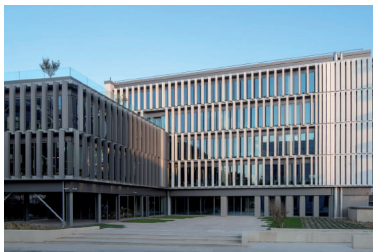
ΚΤΙΡΙΟ BUTTERFLY, ΧΑΛΑΝΔΡΙ ΑΤΤΙΚΗΣ. ΑΡΧΙΤΕΚΤΟΝΙΚΗ ΜΕΛΕΤΗ YAP ARCHITECTS, ΥΛΙΚΑ ΕΠΕΝΔΥΣΗΣ ΣΥΝΘΕΤΑ ΠΑΝΕΛ ΑΛΟΥΜΙΝΙΟΥ ETALBOND®FR.
