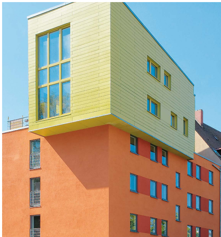
ΚΤΙΡΙΟ ΕΦΑΡΜΟΓΗΣ ΔΙΑΚΟΣΜΗΤΙΚΩΝ ΕΠΙΧΡΙΣΜΑΤΩΝ ΚΝΑΟΥΦ.
