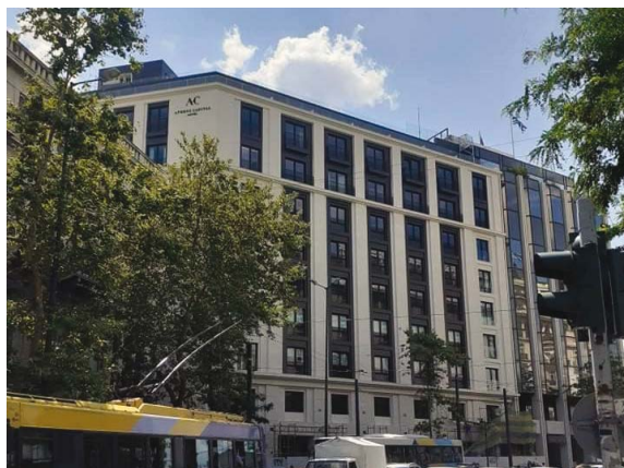
ATHENS CAPITAL HOTEL - M GALLERY COLLECTION. ΘΕΡΜΟΠΡΟΣΩΨΗ 7.000 m 2 ΜΕ FKD-S THERMAL.
