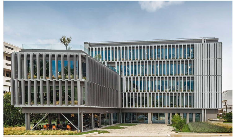
ΚΤΙΡΙΟ ΓΡΑΦΕΙΩΝ BUTTERFLY. ΣΥΝΘΕΤΑ ΠΑΝΕΛ ΑΛΟΥΜΙΝΙΟΥ ΜΕ ΒΡΑΔΥΚΑΣΤΟ ΠΥΡΗΝΑ ETALBOND® FR.
