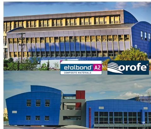
ΑΜΑΞΟΣΤΑΣΙΟ ΜΕΤΡΟ ΘΕΣ/ΝΙΚΗΣ. ΟΦΕΙΣ ΜΕ ΠΡΟΪΟΝΤΑ ETALBOND® A2 ΚΑΙ ΒΑΜΜΕΝΑ ΦΥΛΛΑ ΑΛΟΥΜΙΝΙΟΥ OROFE® ΣΤΙΣ ΟΡΟΦΕΣ.
