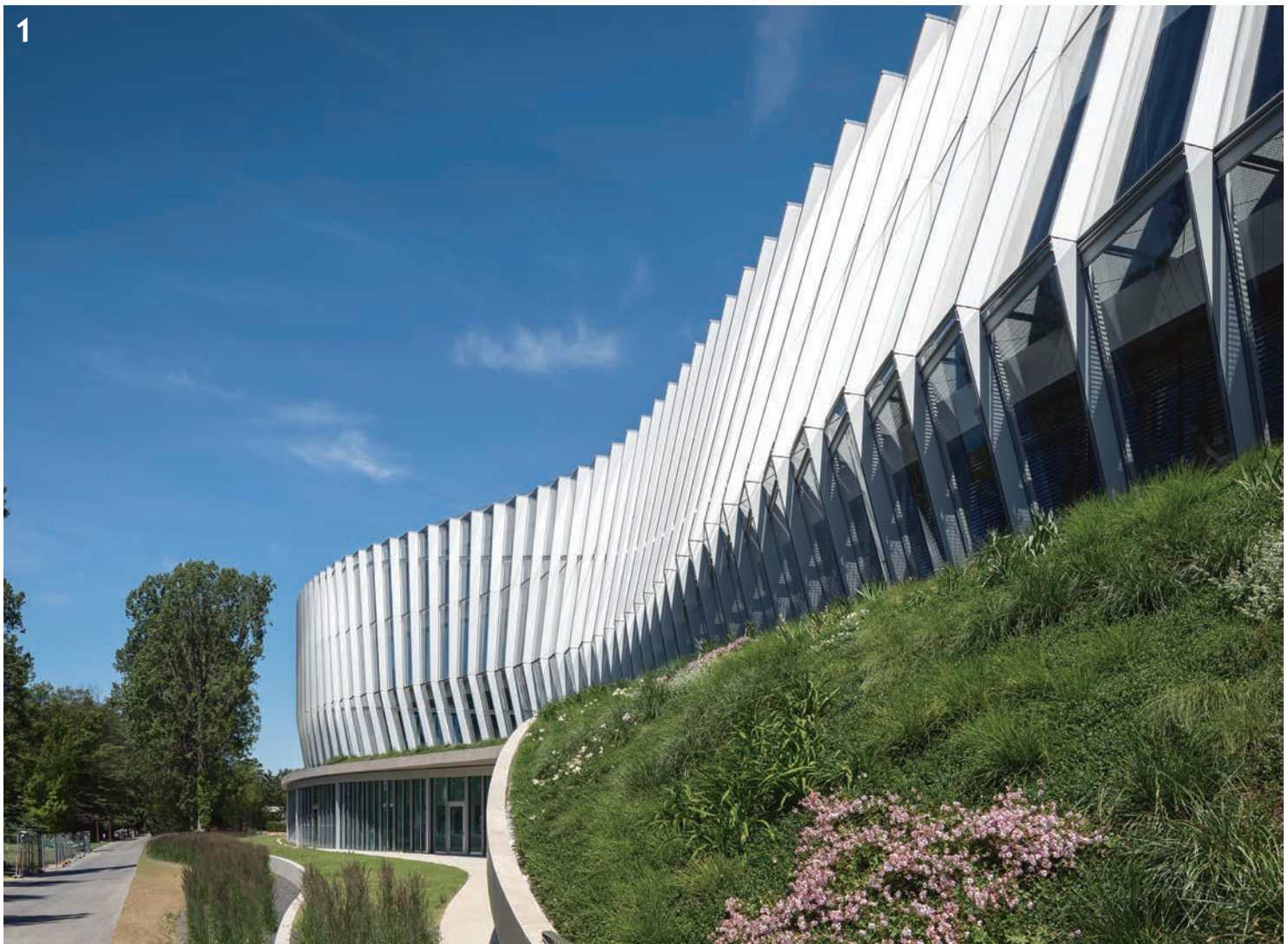
1. Η δικέλυφη πρόσοψη δημιουργεί ένα αποτελεσματικό θερμικό και ηχομονωμένο περίβλημα. Αρχιτεκτονική μελέτη: 3XN Architects Φωτογραφία: International Olympic Committee (IOC) / Mørk Adam.
