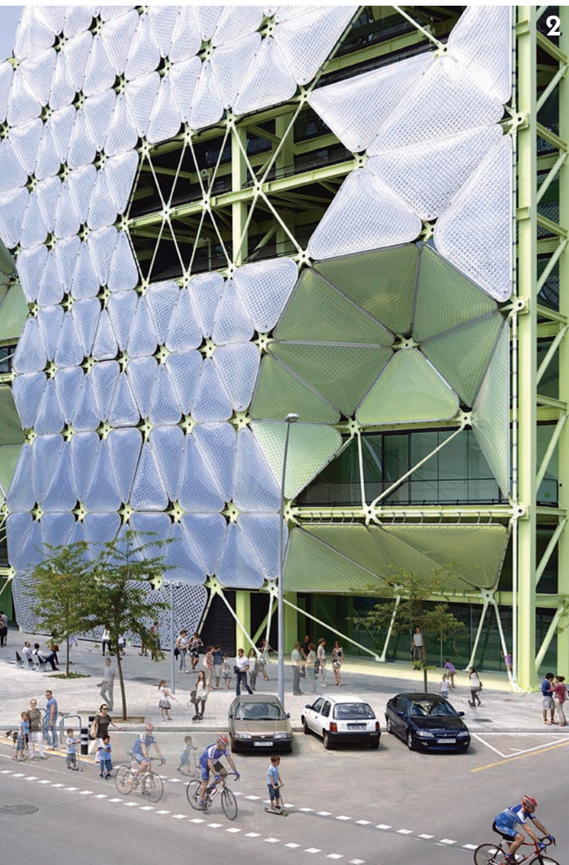
2. Βιοκλιματική όψη κτιρίου γραφείων στη Βαρκελώνη κατασκευασμένη από τριγωνικά πλαίσια ελαστικής μεμβράνης ETFE, δημιουργώντας έτσι ένα δεύτερο κέλυφος. ©Cloud9.
