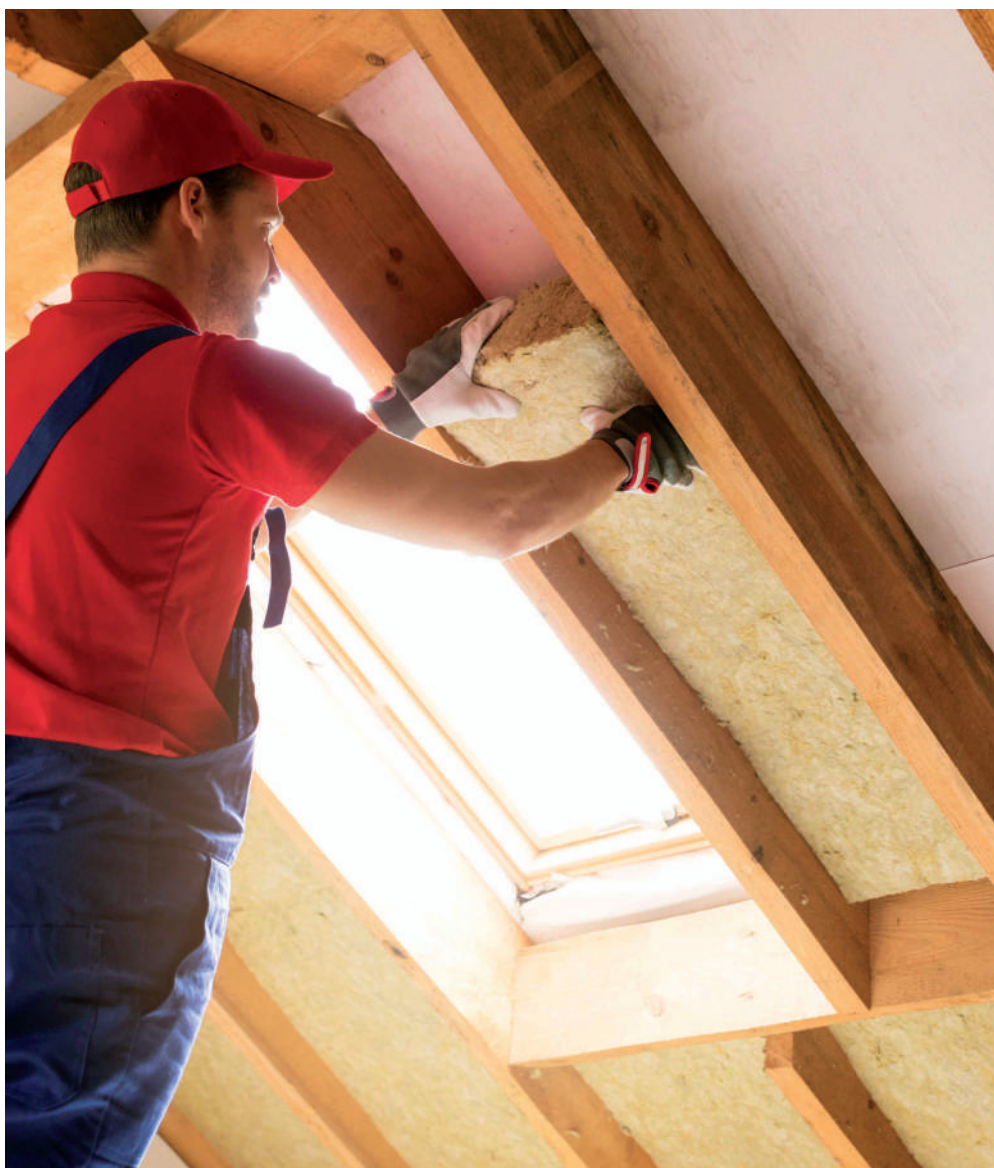
Τοποθέτηση του θερμομονωτικού υλικού ανάμεσα στα στοιχεία του φέροντος οργανισμού. Το μικρότερο πάχος του υλικού σε σχέση με αυτό των αμειβόντων δίνει τη δυνατότητα αυτοί να παραμείνουν εμφανείς εσωτερικά.
