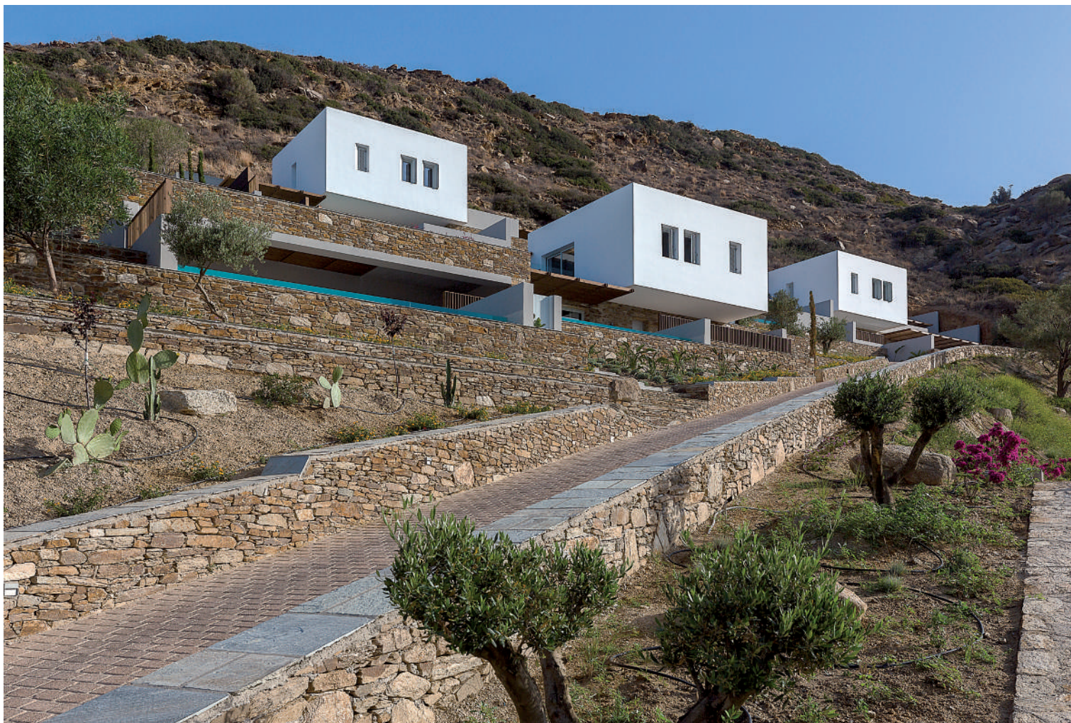
Ο περιβάλλον χώρος των "HIDEOUT SUITES" στην Ίο διαμορφώνεται με τσιμεντοκονίαμα, κυβόλιθους και πέτρες, που χρησιμοποιούνται στην κυκλαδίτικη αρχιτεκτονική. Αρχιτεκτονική μελέτη: GFRA Architecture. Φωτογραφία: Παναγιώτης Βουμβάκης.
