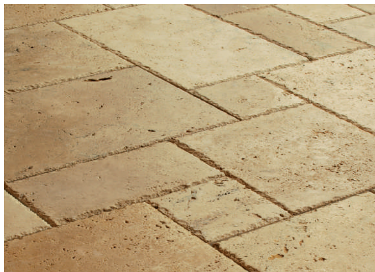
Οι φυσικοί λίθοι μπορούν να υποστούν κατεργασίες για να αποκτήσουν τις επιθυμητές διαστάσεις και κατάλληλο σχήμα, ανάλογα με τις ανάγκες του έργου.
