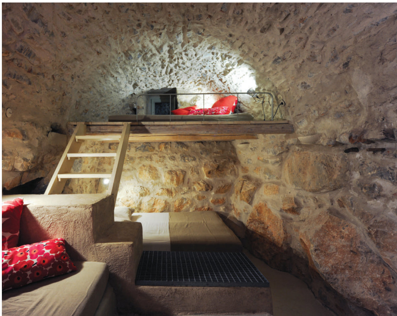
Αναστήλωση και αποκατάσταση ερειπωμένου, μεγαλιθικού, διώροφου κτίσματος του 18ου αιώνα, ανατολικά της Μάνης. Αρχιτεκτονική μελέτη / επίβλεψη: Έλενα Ζερβουδάκη. Εταιρεία z-level. Φωτογραφία: Μπάμπης Λουιζίδης.
