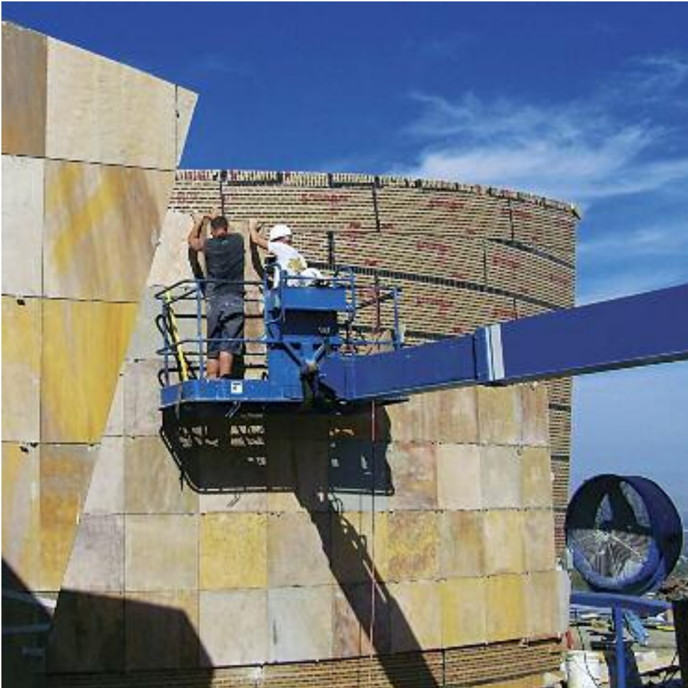
Οι αρμοί μεταξύ των πλακών στην αεριζόμενη όψη μπορεί να καλυφθούν με ελαστική μαστίχη για αισθητικούς λόγους, αλλά δεν σφραγίζονται, ώστε να επιτρέπονται οι μικρομετακινήσεις των πλακών συστολοδιαστολών.
