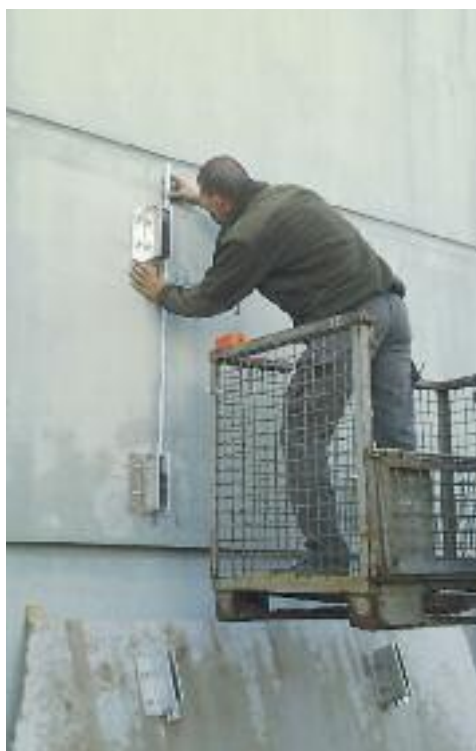
Η τοποθέτηση της επένδυσης πρέπει να γίνεται από εξειδικευμένο συνεργείο, ώστε να διασφαλίζεται η κατακορυφότητα και η ευθυγράμμιση των πλακών.
