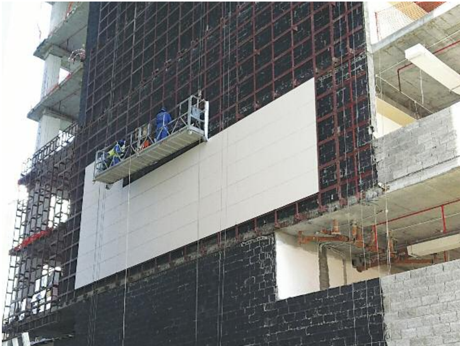
Τοποθέτηση των πλακών με ειδικά συστήματα αγκύρωσης επάνω σε μεταλλικό κάναβο.
