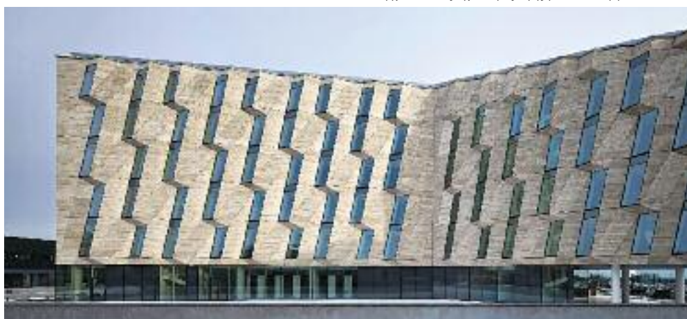
Αρχιτεκτονικός σχεδιασμός όψης με επένδυση φυσικών λίθων.
