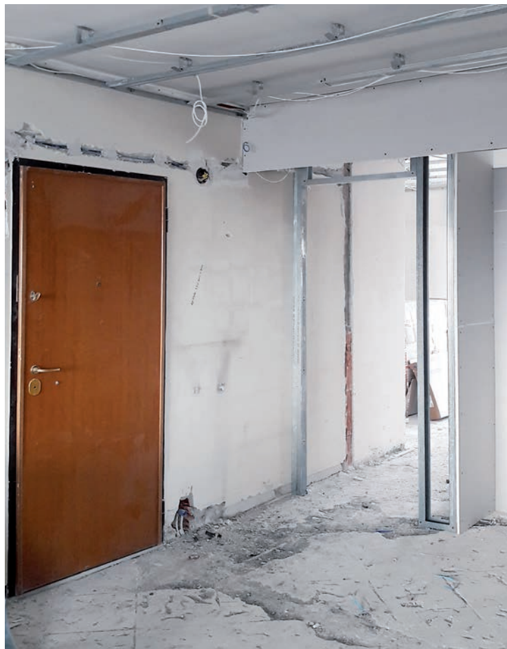
Εσωτερικές τοιχοποιίες και διαμόρφωση οροφής από συστήματα ξηρής δόμησης.
