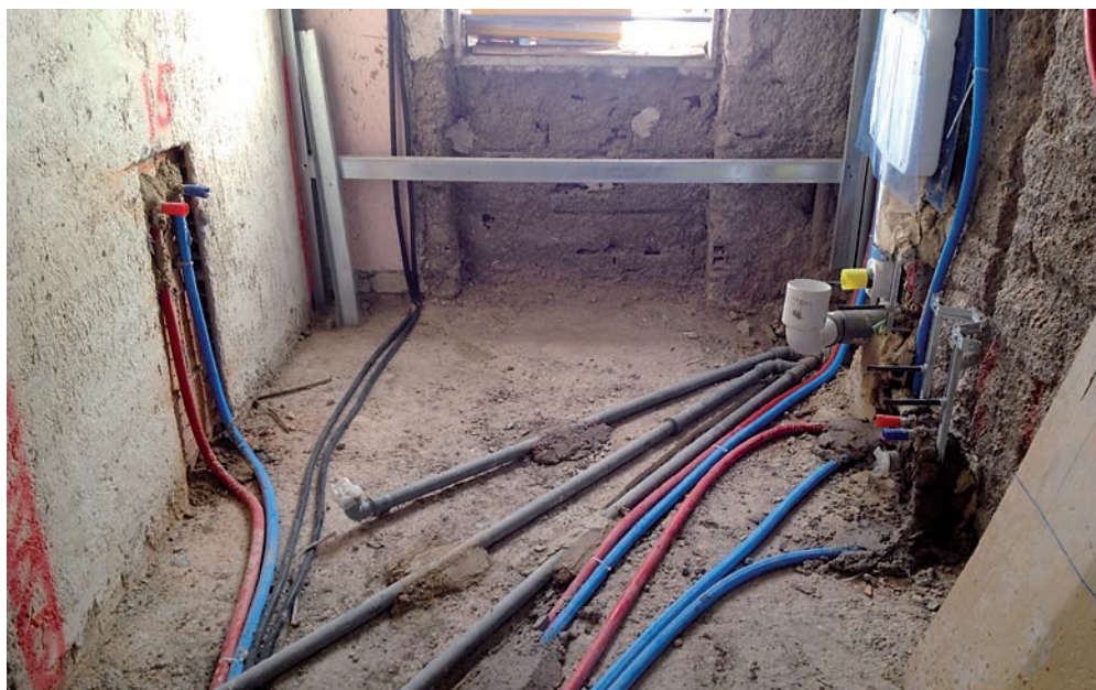
Ανακαίνιση μπάνιου. Εγκατάσταση νέων σωληνώσεων και επιτοίχιου δοχείου έκπλυσης.
