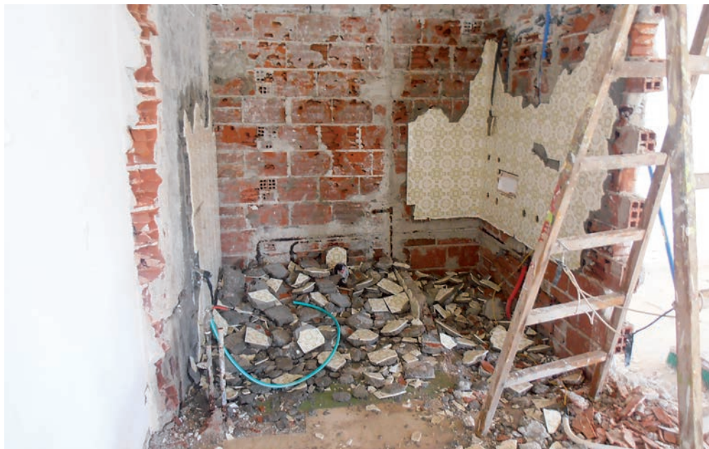
Καθαίρεσεις σε μπάνιο και αποξήλωση πλακιδίων, τα οποία είχαν τοποθετηθεί με τσιμέντο.
