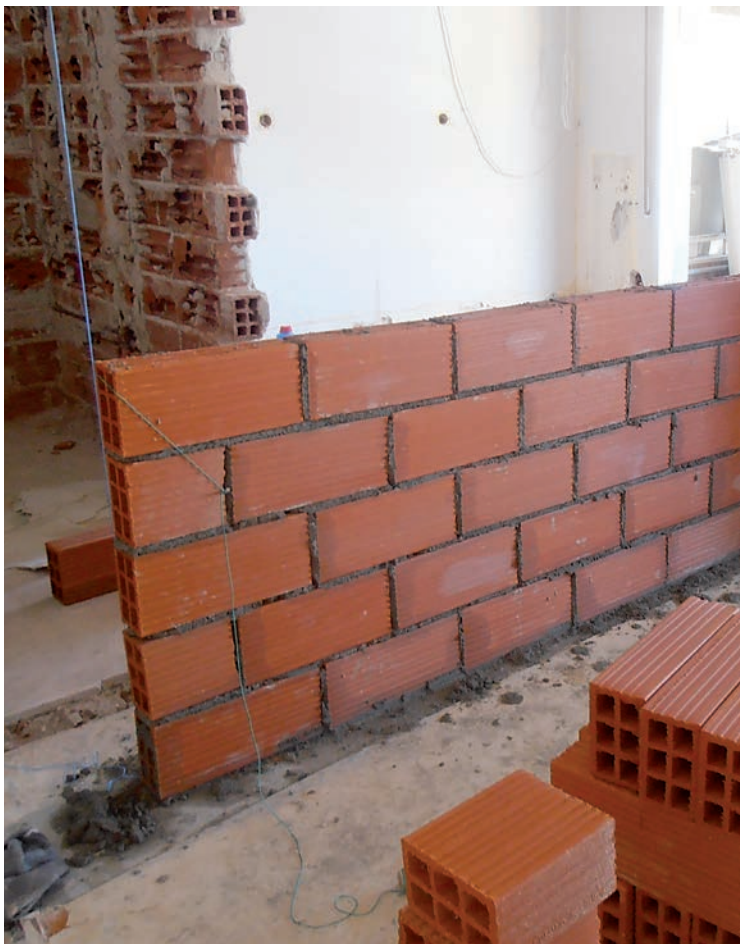
Κατασκευή νέας εσωτερικής δομικής τοιχοποιίας από οπτοπλίνθους.
