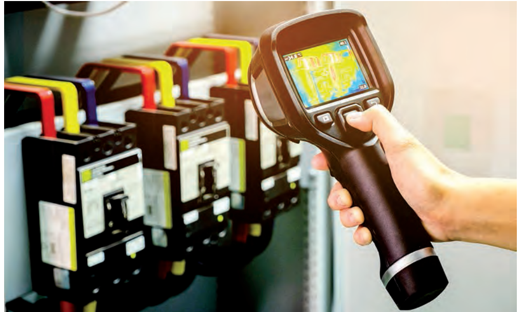
Η θερμογραφία χρησιμοποιείται για τη διάγνωση δυσλειτουργίας των ηλεκτρομηχανολογικών εγκαταστάσεων.
