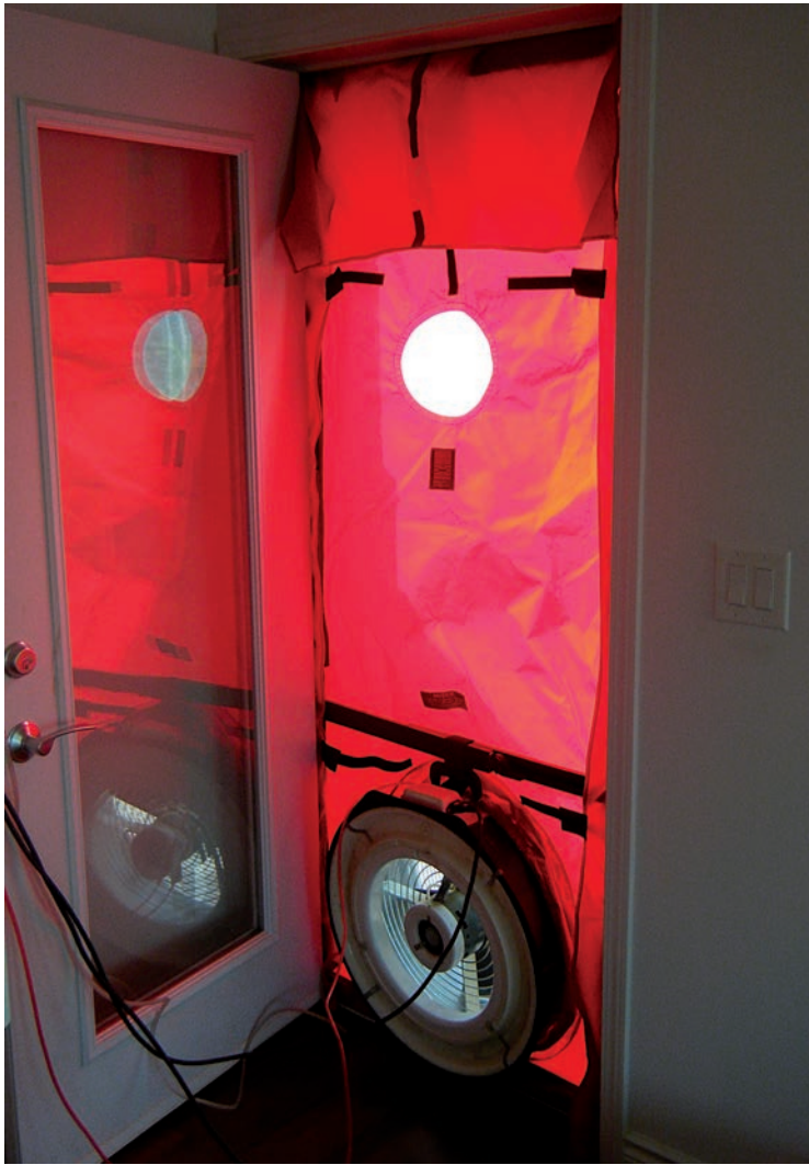
Ο εντοπισμός της διαφυγής ή εισροής αέρα διευκολύνεται, εντείνοντας το φαινόμενο με τη χρήση ειδικού ανεμιστήρα και δημιουργώντας διαφορά πίεσης μεταξύ του εσωτερικού και εξωτερικού χώρου του κτιρίου.
