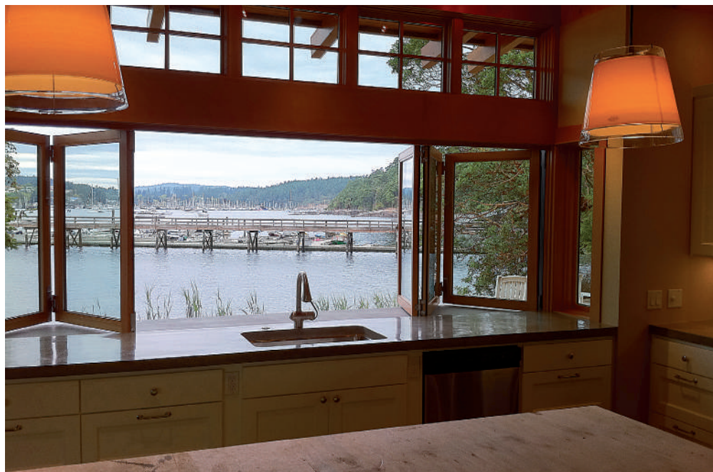
Τα πτυχωτά ξύλινα κουφώματα μπορούν να χρησιμοποιηθούν για να καλύψουν μεγάλα ανοίγματα και προσφέρουν τη δυνατότητα πλήρους αναδίπλωσης, χωρίς να αφήνουν σταθερά στοιχεία που παρεμποδίζουν τη θέα.
