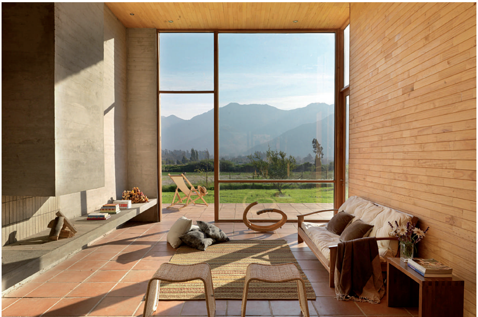
Σταθερά και ανοιγόμενα τμήματα συνδυάζονται και συνθέτουν μια μεγάλη επιφάνεια, η οποία προσφέρει διαφάνεια στην όψη. Για την αποδοτική λειτουργία ενός κουφώματος πρέπει να χρησιμοποιείται ξυλεία καλής ποιότητας, χωρίς ελαττώματα. Κατοικία στη Χιλή. Αρχιτεκτονική μελέτη: Alejandro Dumay, Francisco Vergara.
