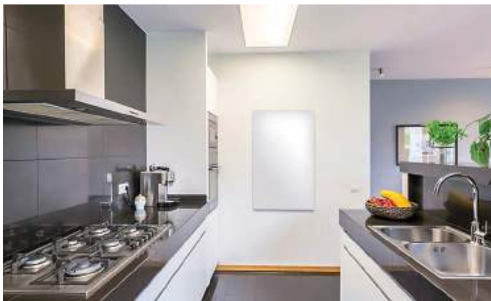
Θέρμανση με υπέρυθρο πέτασμα σε τοιχοποιία κουζίνας.
