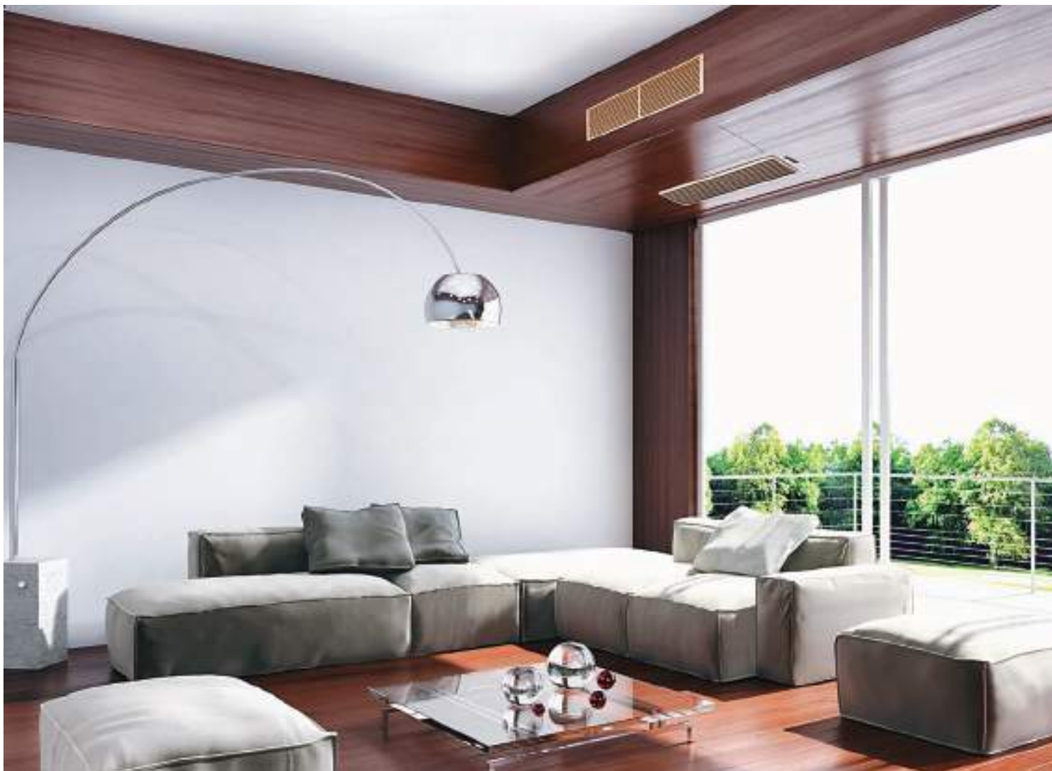
Η κρυφή εσωτερική μονάδα οροφής αντλίας θερμότητας αέρα - αέρα τοποθετείται σε οροφή με επένδυση ξύλου. Η μερική επένδυση της οροφής εξυπηρετεί την τοποθέτηση του πλαινού στομίου και τη διατήρηση του ύψους του ορόφου.
