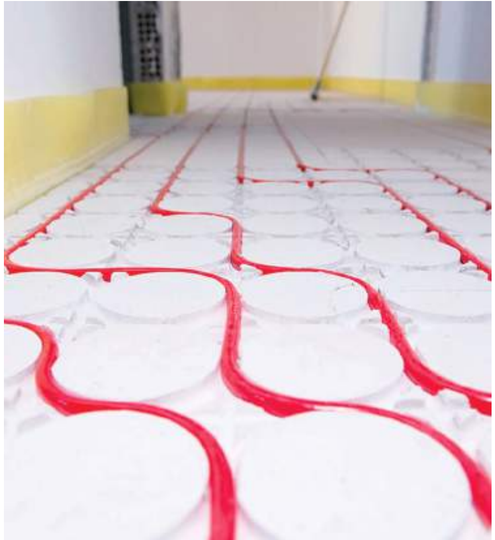
Σύστημα ενδοδαπέδιας θέρμανσης ξηρής δόμησης με ειδικές ινοσανίδες, ιδανικό για τελικό δάπεδο μικρού πάχους.
