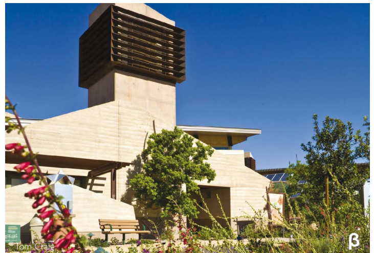
Κατακόρυφη καθοδική κίνηση του αέρα σε συνδυασμό με εξάτμιση. Ανεμόπυργοι (Badgir Yazd) στη Yazd (α) και πύργος καθοδικού ρεύματος (PDEC tower) στο Desert Living Center, Λας Βέγκας, Νεβάδα, Η.Π.Α. (β).
