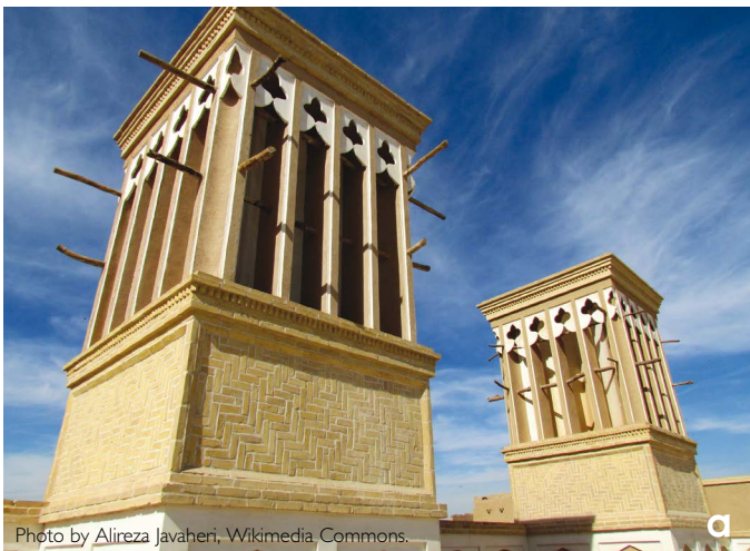
Κατακόρυφη καθοδική κίνηση του αέρα σε συνδυασμό με εξάτμιση. Ανεμόπυργοι (Badgir Yazd) στη Yazd (α) και πύργος καθοδικού ρεύματος (PDEC tower) στο Desert Living Center, Λας Βέγκας, Νεβάδα, Η.Π.Α. (β).
