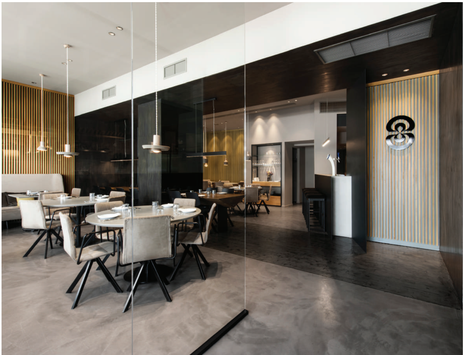
Στο εστιατόριο, που σχεδίασε το αρχιτεκτονικό γραφείο MALVI, τοποθετήθηκαν διάφοροι τύποι στομιών (επιτοίχιοι και οροφής), οι οποίοι βράφηκαν, όπου χρειάστηκε, στο επιθυμητό χρώμα. © Γιώργος Παπαδόπουλος.
