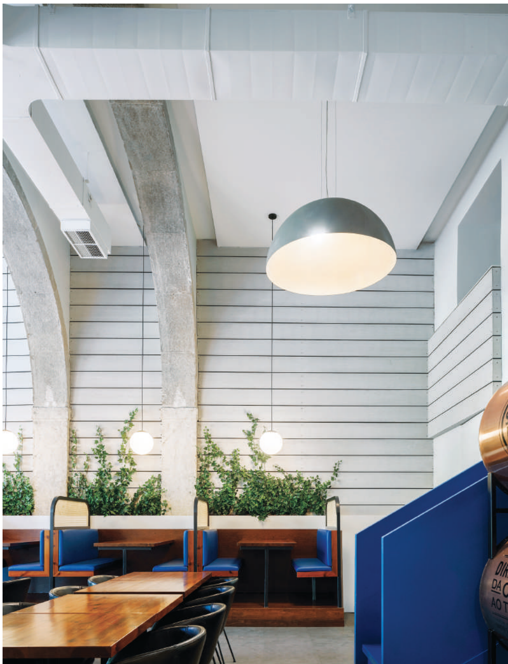
Εμφανείς αεραγωγοί και στόμια ορθογωνικού σχήματος στο χώρο ανάπτυξης τραπεζοκαθισμάτων εστιατορίου στην Αγ. Πετρούπολη. Αρχιτεκτονική μελέτη: DA BUREAU. © Mikhail Loskutov.
