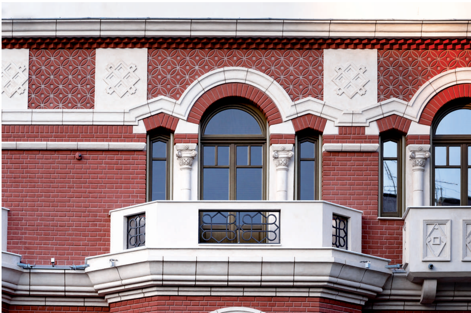
Κατά την αποκατάσταση του εμβληματικού Μεγάρου Λόγγου στη Θεσσαλονίκη στις εξωτερικές τοιχοποιίες επιλέχθηκε επένδυση σταμπωτού κοκκινόχρωμου κονιάματος σε απομίμηση συμπαγούς πλίνθου. Αρχιτεκτονική μελέτη: Γ. Παυλίδης, Π. Σαρβάνη, Β. Μάσεν. © Γεωργία Ασλανίδου.
