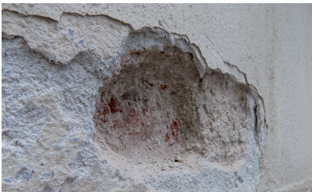
Θέση δειγματοληψίας σε ιστορική τοιχοποιία και διαστρωμάτωση επιχρισμάτων σε τρία στρώματα: το εσωτερικό έχει ροζ χροιά, το ενδιάμεσο είναι υπόλευκο και το εξωτερικό αποτελεί λεπτή επικάλυψη.
