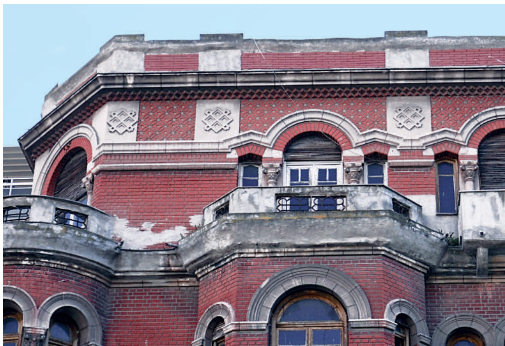
Αποψη του Μεγάρου Λόγγου πριν από τις εργασίες αποκατάστασης, τα τραβηχτά κονιάματα και τα σταμπωτά επιχρίσματα παρουσίαζαν άρτια τεχνική εφαρμογή, με αποτέλεσμα τη διατήρησή τους σε καλή κατάσταση. © Γεωργία Ασλανίδου.
