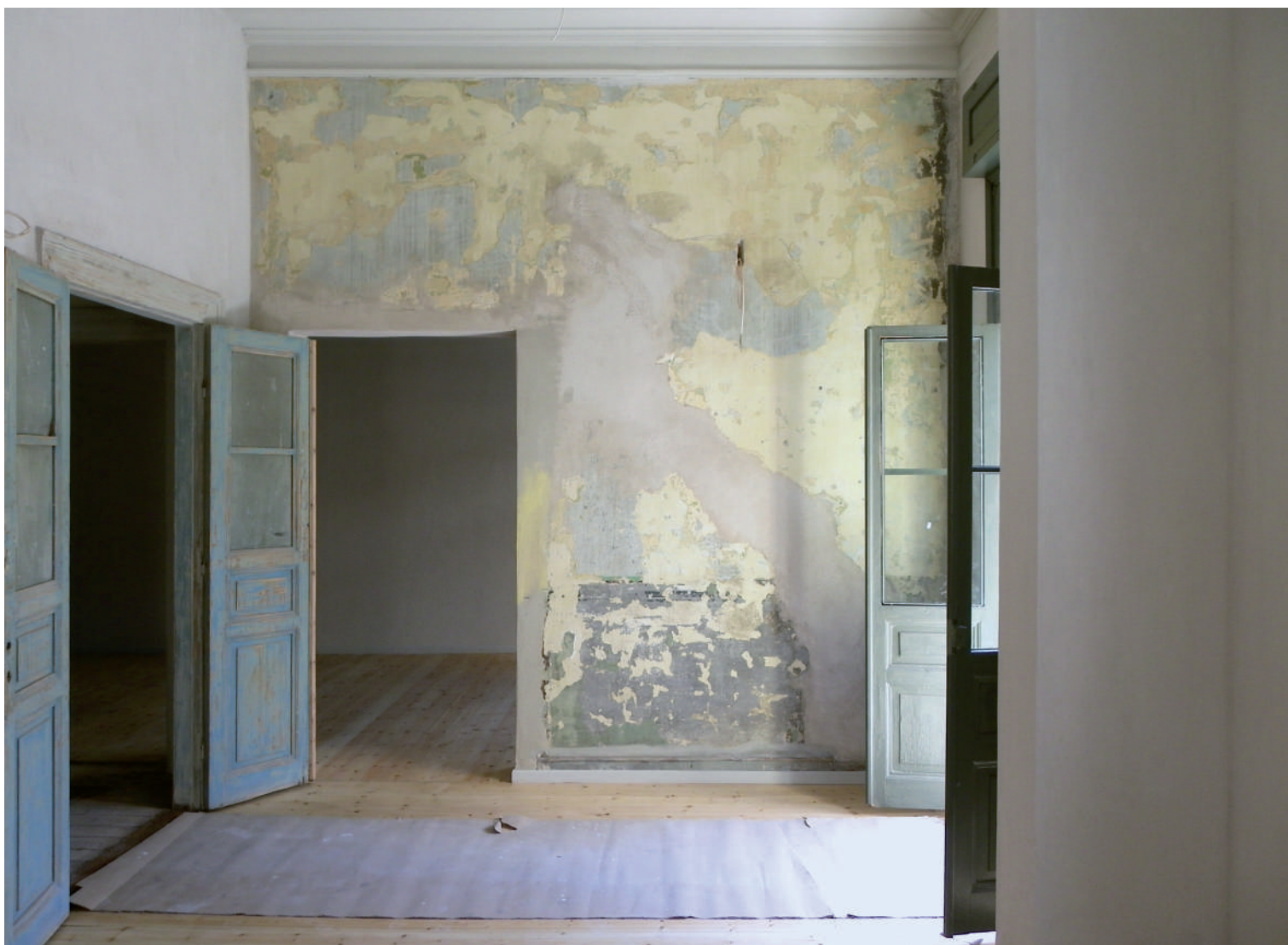
Κατά την αποκατάσταση του διατηρητέου κτιρίου Κύρση Χαν στη Θεσσαλονίκη, οι τοιχοποιίες του ορόφου παρέμειναν ανεπίχριστες στις περιοχές, στις οποίες δεν υπήρχαν εκτεταμένες επισκευές. Αρχιτεκτονική μελέτη: Σ. Χατζηγεωργίου. © Γιούλη Περδίκη (CAN Studio).
