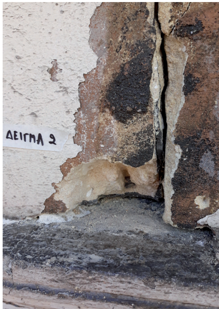
Αστοχία από χρήση ακατάλληλων υλικών επέμβασης.
