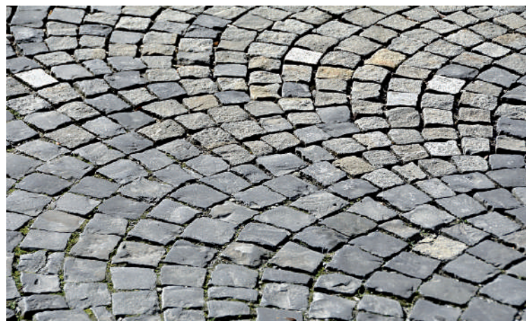
Η εφαρμογή υδατοδιαπερατών υλικών, όπως κυβόλιθων, πατημένου χώματος, χαλικιών κτλ., ενισχύει το δροσισμό, επιτρέποντας την εξάτμιση των υδάτων κατά τις θερμές περιόδους.
