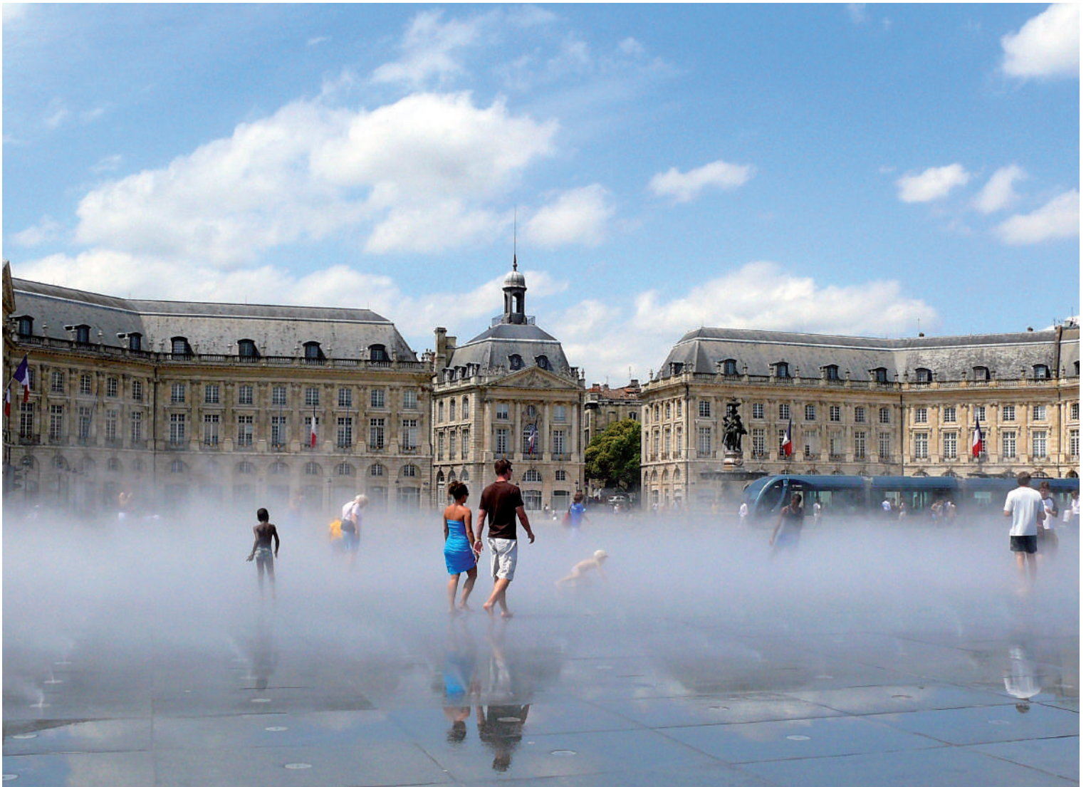
Σύστημα τεχνητής ομίχλης στο δάπεδο της Floodable Square - Miroir d' Eau, Bordeaux, Γαλλία (JML Arquitectura del Agua, 2006).
