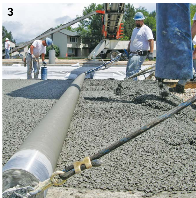
3. Επιπέδωση και συμπύκνωση πορώδους σκυροδέματος με κυλινδρικό δονητικό πήχη βαρέος τύπου.
