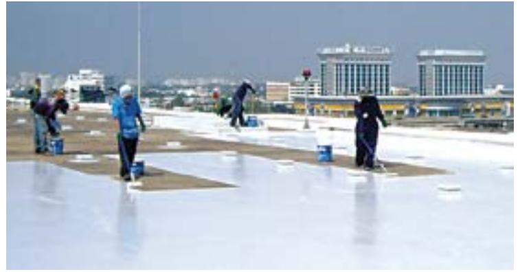
ΤΟ MARISEAL® 460 ΕΙΝΑΙ ΚΑΤΑΛΛΗΛΟ ΓΙΑ ΕΦΑΡΜΟΓΗ ΥΓΡΟΜΟΝΩΣΗΣ ΜΕΣΑ ΣΕ ΜΙΑ ΗΜΕΡΑ, ΚΑΘΩΣ ΜΕΤΑ ΤΗΝ ΕΦΑΡΜΟΓΗ ΤΟΥ ΣΤΕΓΝΩΝΕΙ ΠΟΛΥ ΓΡΗΓΟΡΑ.
