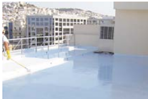
ΤΟ MARISEAL® 460 ΠΕΡΙΕΧΕΙ ΚΑΤΑΛΥΤΗ ΚΑΙ ΠΑΡΕΧΕΙ ΜΕΜΒΡΑΝΗ ΧΩΡΙΣ ΦΥΣΑΛΙΔΕΣ ΚΑΙ ΟΠΕΣ, ΑΚΟΜΗ ΚΑΙ ΑΝ ΕΦΑΡΜΟΣΤΕΙ ΣΕ ΜΕΓΑΛΟ ΠΑΧΟΣ.
