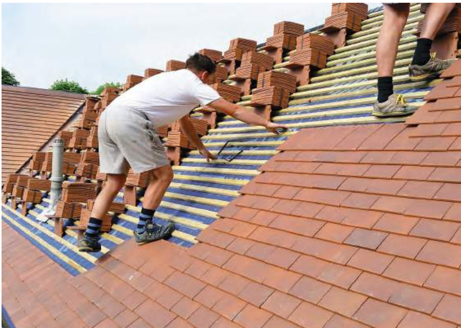
Τοποθέτηση επίπεδων κεραμιδιών σε στέγη. Η επάνω σειρά οφείλει να επικαλύπτει περίπου κατά το ήμισυ την από κάτω και τα κεραμίδια να τοποθετούνται σε κάθε σειρά μετατοπισμένα κατά το ήμισυ του πλάτους τους.
