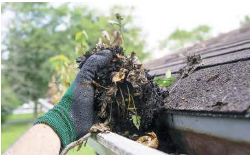
Οι εργασίες συντήρησης των υδρορροών της στέγης περιλαμβάνει την απομάκρυνση των φερτών υλών.
