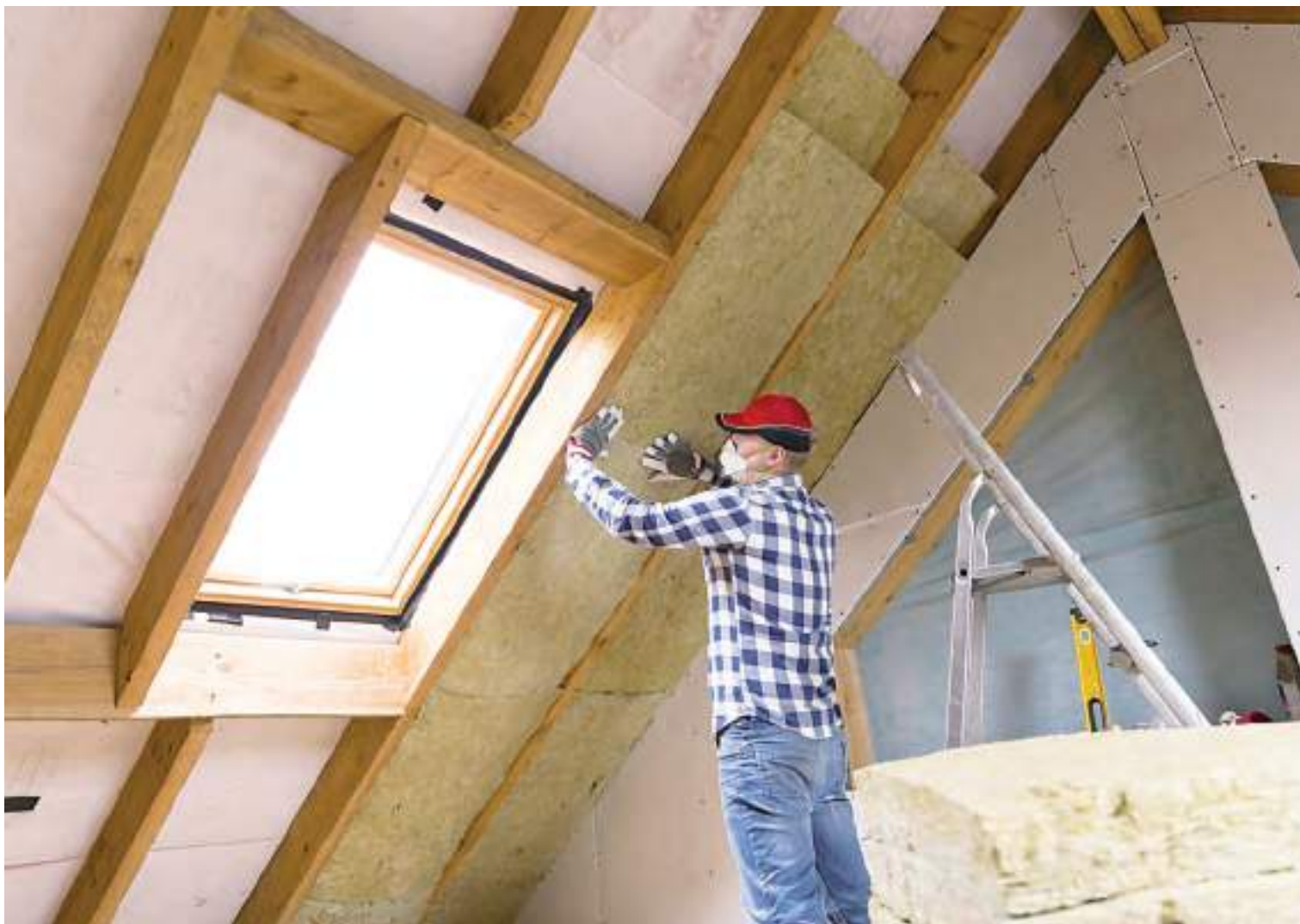
Τοποθέτηση θερμομονωτικού υλικού σε υφιστάμενη ξύλινη στέγη. Επιλέγεται υλικό σε μορφή παπλώματος, ώστε να προσαρμόζεται στις θέσεις μεταξύ των αμειβόντων.
