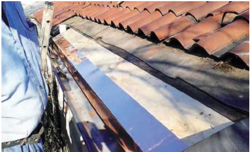
Αντικατάσταση του μεταλλικού προφίλ στη μαρκίζα της στέγης με νέο. Η στερέωσή του γίνεται κάτω από τη στεγανοποιητική μεμβράνη, επάνω στο σανίδωμα της στέγης.
