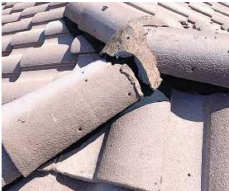
Οι κορφιάδες είναι ευάλωτα σημεία σε αποκολλήσεις. Οι εργασίες επισκευής περιλαμβάνουν την καθαίρεση των υπολειμμάτων κονιάματος και την επικόλληση του νέου κορυφοκέραμου με ειδικό σφραγιτικό κονίαμα με στεγανοποιητική δράση.
