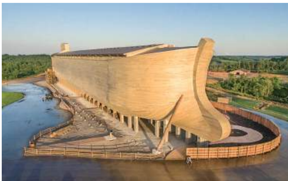
Η τεχνολογία της θερμικής τροποποίησης παράγει ξυλεία με αντοχή, υδροφοβία και βελτιωμένη βιολογική ανθεκτικότητα. Εφαρμογή της σε κελυφος κτιρίου.
