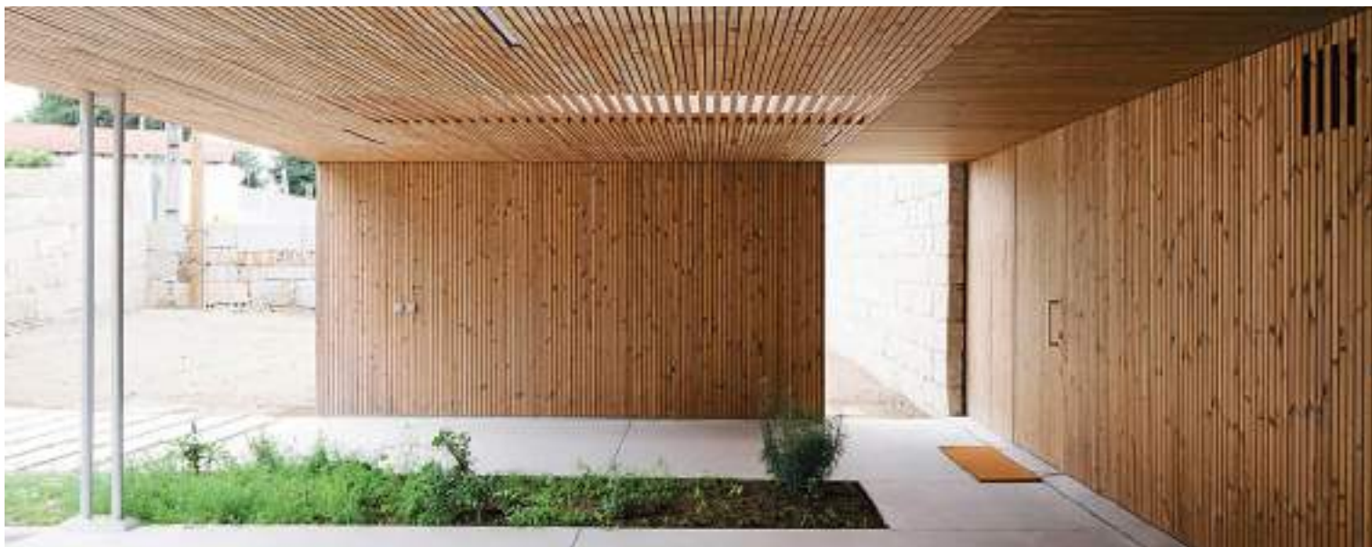
Τα λεγόμενα "thermowood" (θερμική τροποποίηση) έχουν αυξημένη διαστασιακή σταθερότητα, υδροφοβία και ανθεκτικότητα απέναντι σε μύκητες και έντομα.
