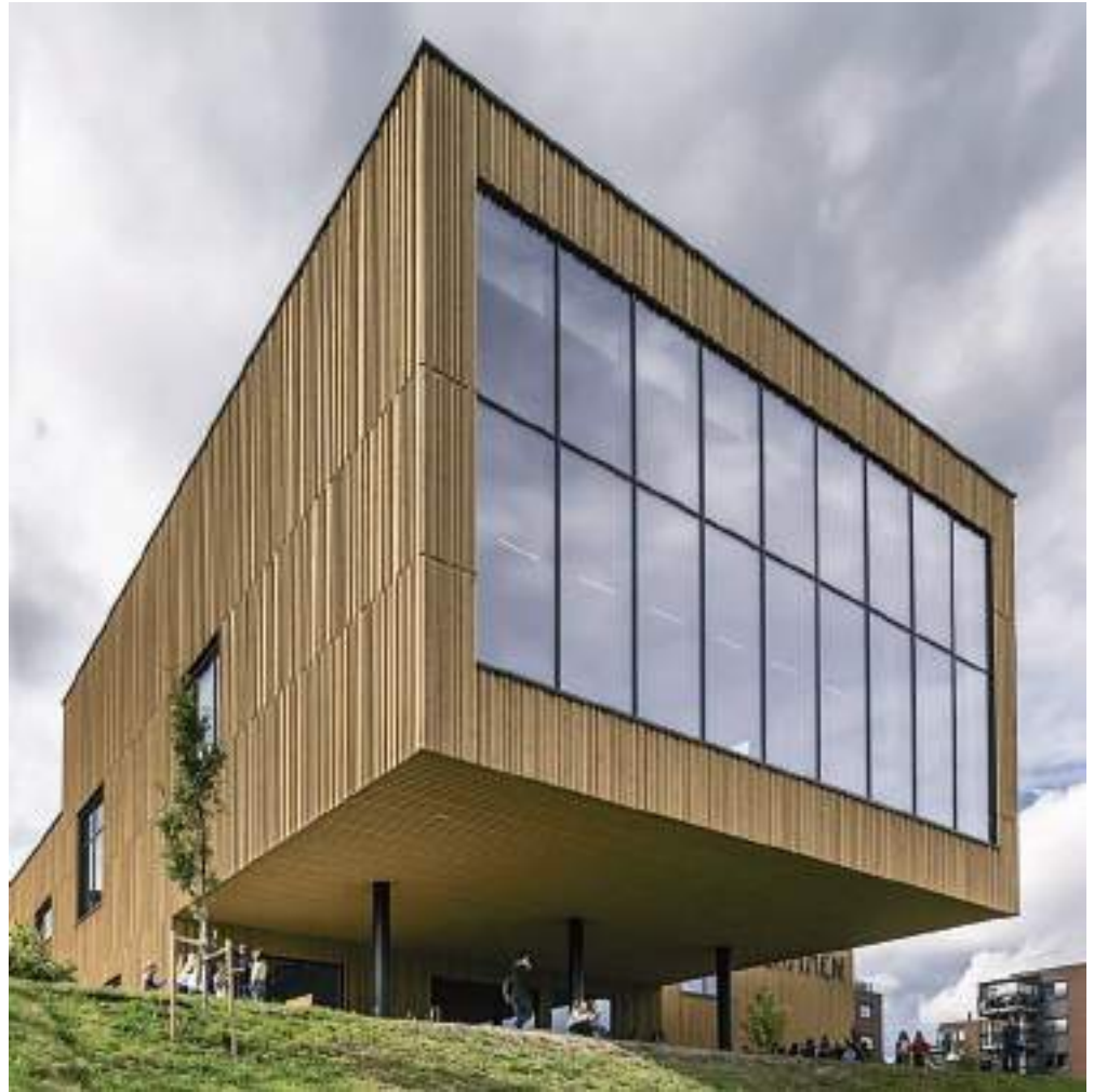
Στο πολιτιστικό κέντρο του Nittedal στη Νορβηγία, των L2 arkitekter, όλες οι προσόψεις είναι κατασκευασμένες από ξυλεία εμποτισμένη με υπερκρίσιμο διοξείδιο του άνθρακα (Superwood®).
